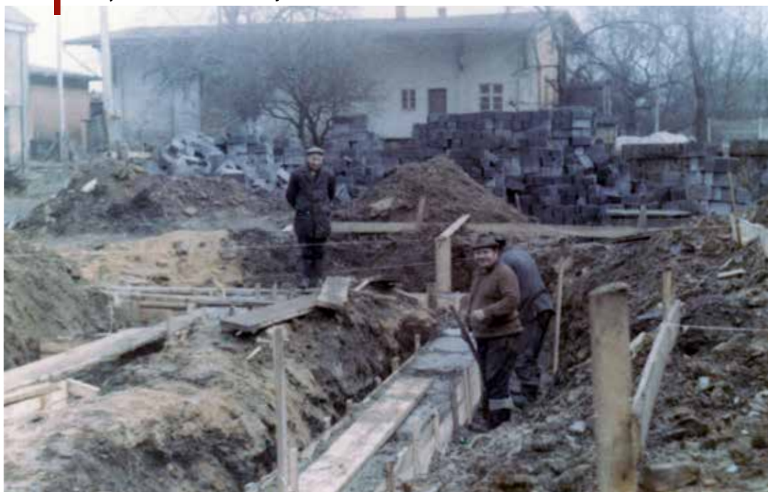
1981 Výstavba nové hasičské zbrojnice
