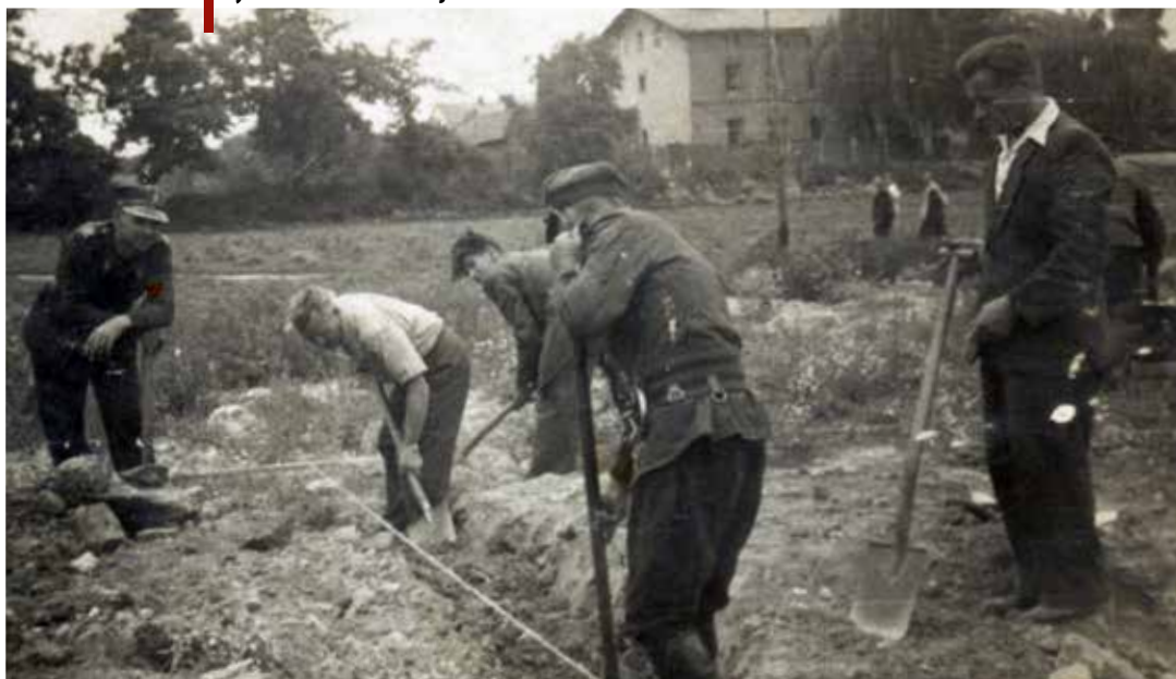
Výstavba hasičské zbrojnice v rosírně
