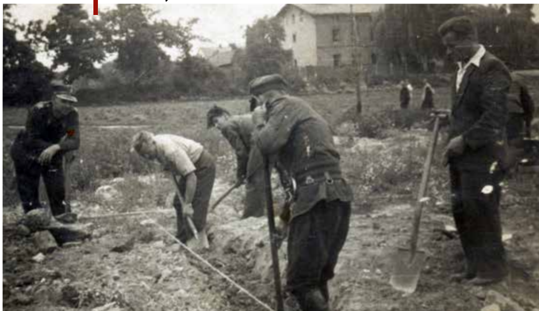
Budowa remizy w roszarni
